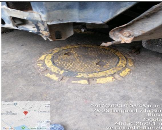
**Fotografía No. 4.** Boca de llenado de tanque de almacenamiento.
